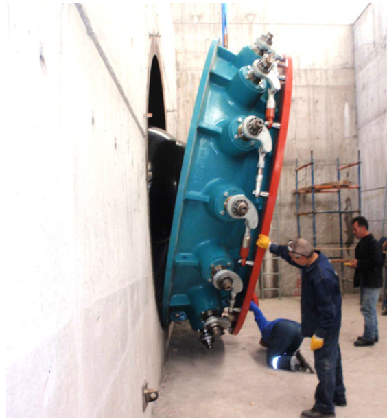
La fase di montaggio di un macchinario per il mini idroelettrico: ogni turbina va disegnata per il sito specifico
